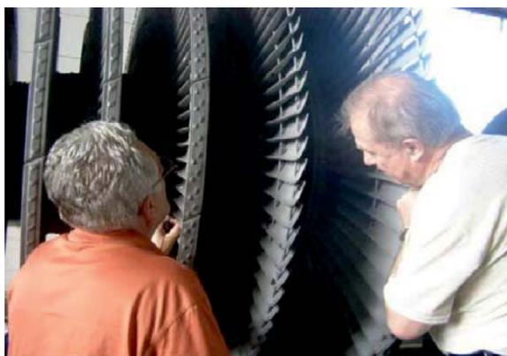
Нанесение металлизатором защитных покрытий на входную и выходную кромки рабочих лопаток 29-й ступени через конденсатор при текущем ремонте турбины К-300-240 ЛМЗ ОАО «Рязанская ГРЭС» (ТГ-3).
